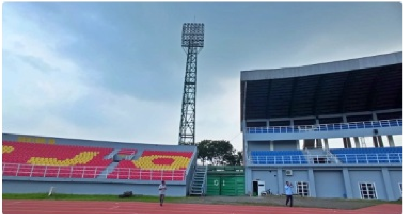
Lampu Stadion Gelora Delta Sidoarjo di tower 1 yang tidak bisa menyala sempurna.
