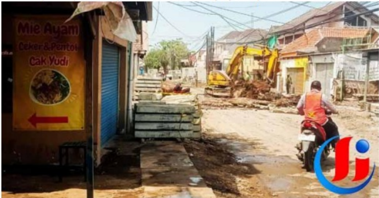
Tak Dapat Kompensasi Proyek Betonisasi Jalan, Pedagang Sidoarjo: Kami Dimatikan Perlahan
