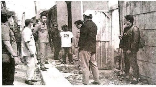
Wakil Bupati Sidoarjo H. Subandi sidak proyek saluran air Desa Entalsewu kec. Buduran Senin (5/9/22)
