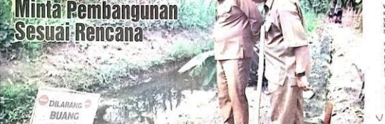
DILARANG BUANG SAMPAH. Para pekerja sedang mengerjakan saluran air di Desa Entekowon, Kecamatan Badaran, yang kurang baik rencana.
