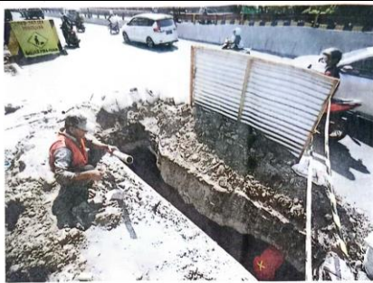
PERBAIKAN: Pekerja dari PDAM Unit Waru mengganti pipa yang keropos di bawah flyover Waru kemarin.
