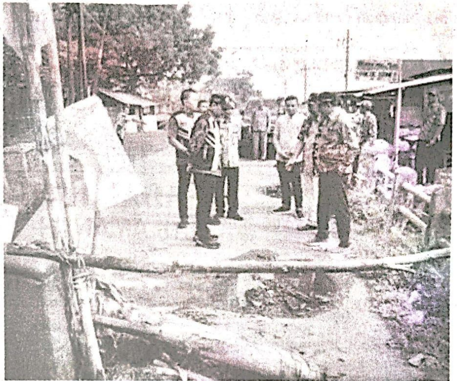
Wakil Bupati Sidoarjo Subandi meninjau jembatan rusak di Desa Prasung, Buduran.
