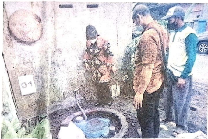
BANTU WARGA: Pembangunan jamban yang dilakukan pada 2022 lalu.
