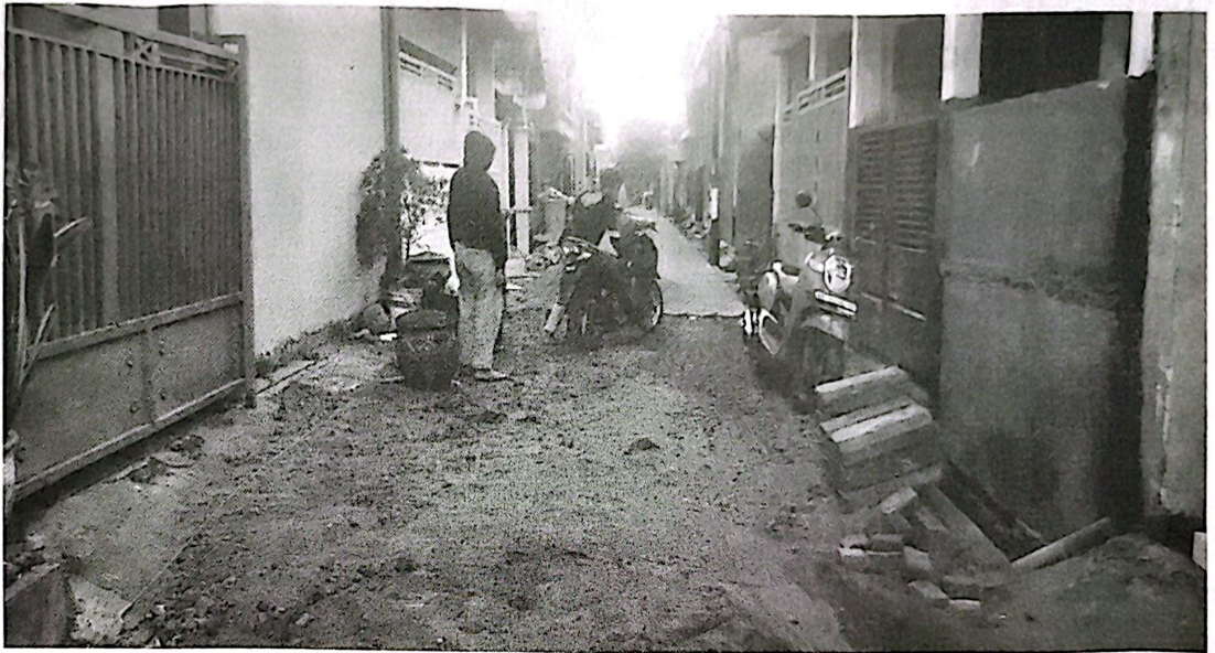
Peningkatan Jl Pemukiman Bodong tanpa Papan Nama Proyek.
