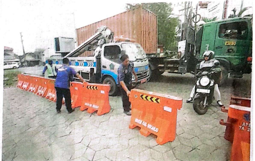
REKAYASA LALU LINTAS: Petugas memasang pembatas jalan di akses masuk Jalan Lingkar Timur Buduran kemarin (24/4). Tujuannya, para pengendara dari frontage road tidak menerobos.
