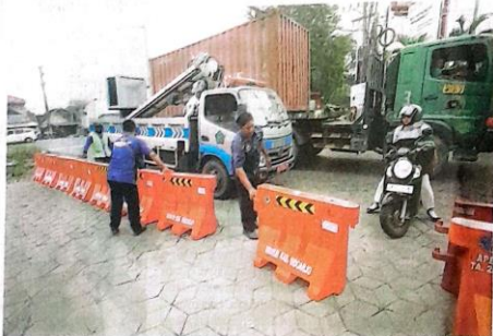
REKAYASA LALU LINTAS: Petugas memasang pembatas jalan di akses masuk Jalan Lingkar Timur Buduran kemarin (24/4). Tujuannya, para pengendara dari frontage road tidak menerobos.
