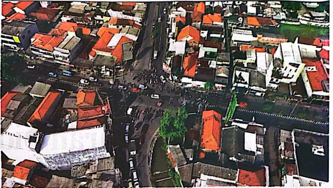
LANGGANAN MACET - Kondisi Perempatan Gedangan yang menjalani langganan macet. Tahun depan pemerintah bakal membangun flyover atau jembatan layang di atas perempatan tersebut.
