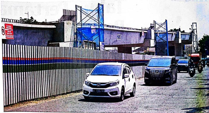
GIRDER MULAI DIPASANG: Kendaraan melintas di sekitar balok beton (erection girder) yang sudah terpasang di tiang penyangga proyek flyover Aloha kemarin (16/7).
