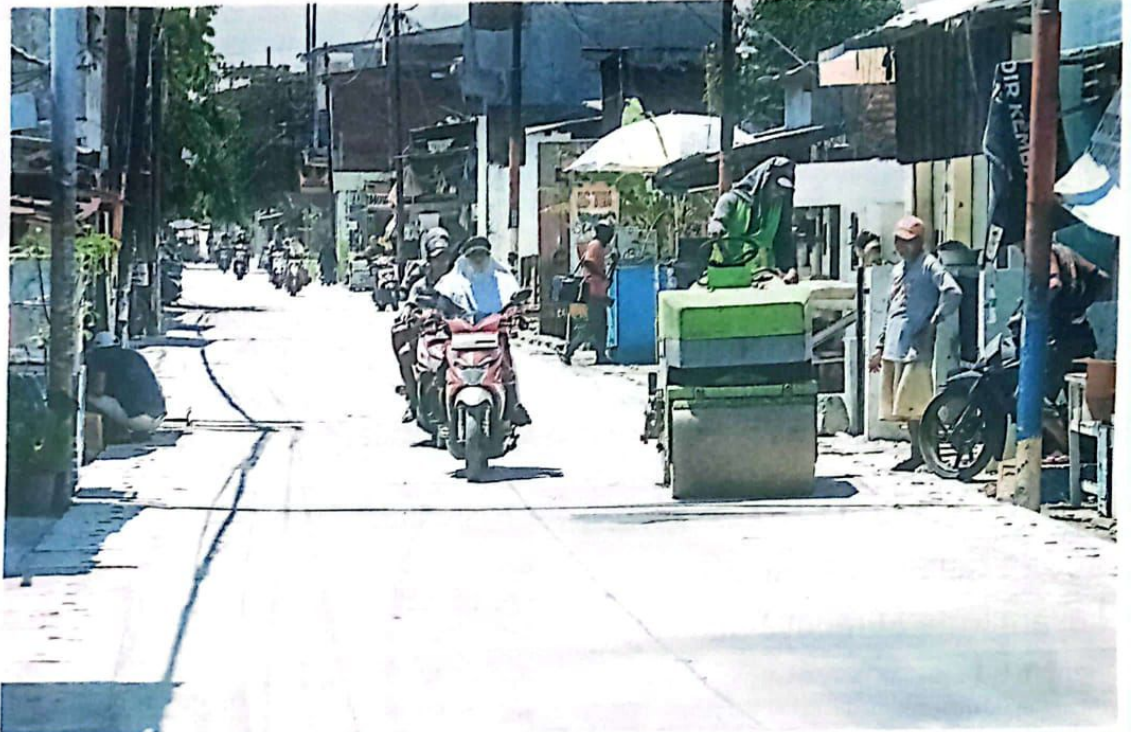
TUNTAS AWAL BULAN: Pengguna jalan melintas di Jalan Tropodo I yang masih dalam proses betonisasi kemarin (22/11). Pembangunan fisik betonisasi di Jalan Tropodo I sudah mencapai 95 persen.
