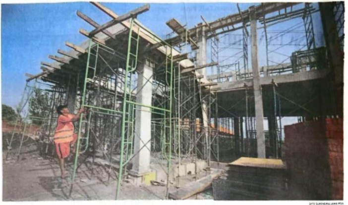
LANJUTAN: Kondisi proyek pembangunan SMPN 2 Tulangan, Sidoarjo, kemarin (11/8)
