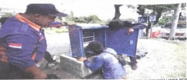
PERBAIKAN: Petugas Dinas Perhubungan Kabupaten Sidoarjo mengganti panel rambu lalu lintas di pertigaan Jalan Raya Pagerwojo kemarin.
