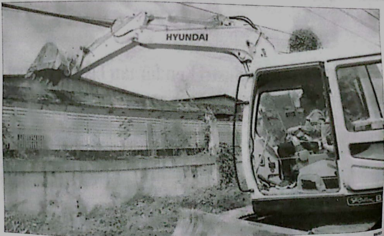
DIBONGKAR: Bupati Muhdlor mencoba naik ekskavator membongkar bangunan untuk FR segmen 2 beberapa waktu lalu.
