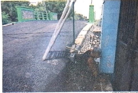
NYARIS KELAR: Warga menunjukkan akses rumah yang terdampak pembangunan Jembatan Prasung.
