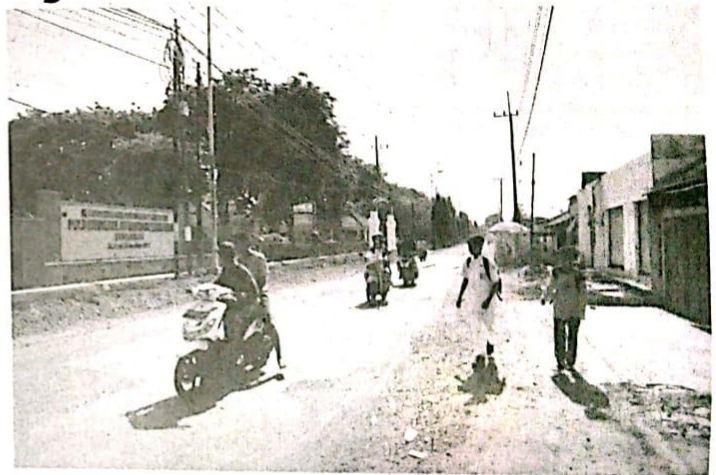
DIBETON - Proyek betonisasi menuju delapan desa di kawasan kampung nelayan, Kecamatan Sedati, Sidoarjo mulai dikerjakan dan ditargetkan selesai akhir Tahun 2022 mendatang, Senin (19/09/2022).
