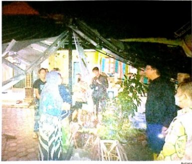
▲ Bupati Sidoarjo Ahmad Muhdlor (baju hitam) meninjau warga yang rusak kena terjerangan angin kencang.
