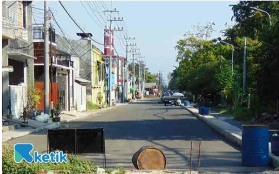
Salah satu ruas frontage road Sidoarjo yang menghubungkan Waru dan Buduran. (Foto: Fathur Rozi/Ketik)
