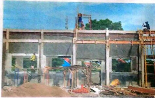
BARU SETENGAH: Pekerja menyelesaikan pembangunan gedung SMPN 2 Tulangan, Sidoarjo, kemarin (29/11). Targetnya selesai akhir tahun.
