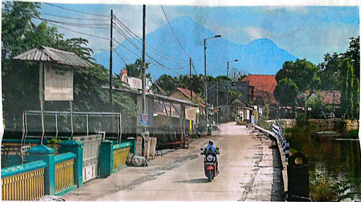
SELESAI LEBIH CEPAT: Pengendara melintas di ruas jalan Tulangan- Durungbedug yang baru selesai dibeton kemarin (29/11).
