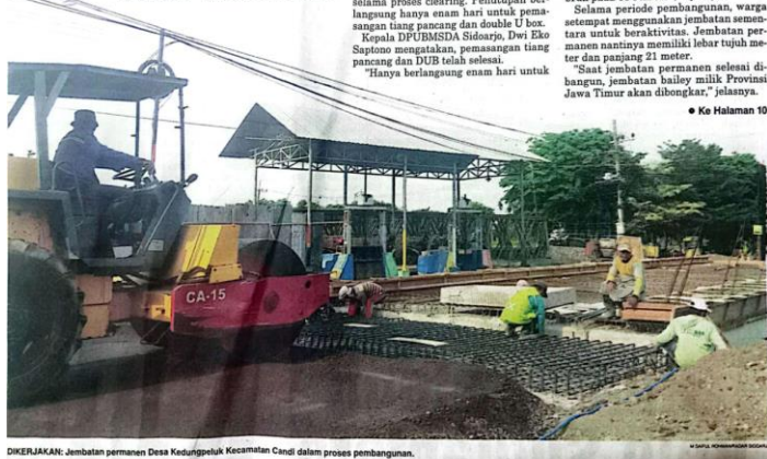
KERJAJARAN: Jembatan permanen Desa Kedungpeluk Kecamatan Candi dalam proses pembangunan.
