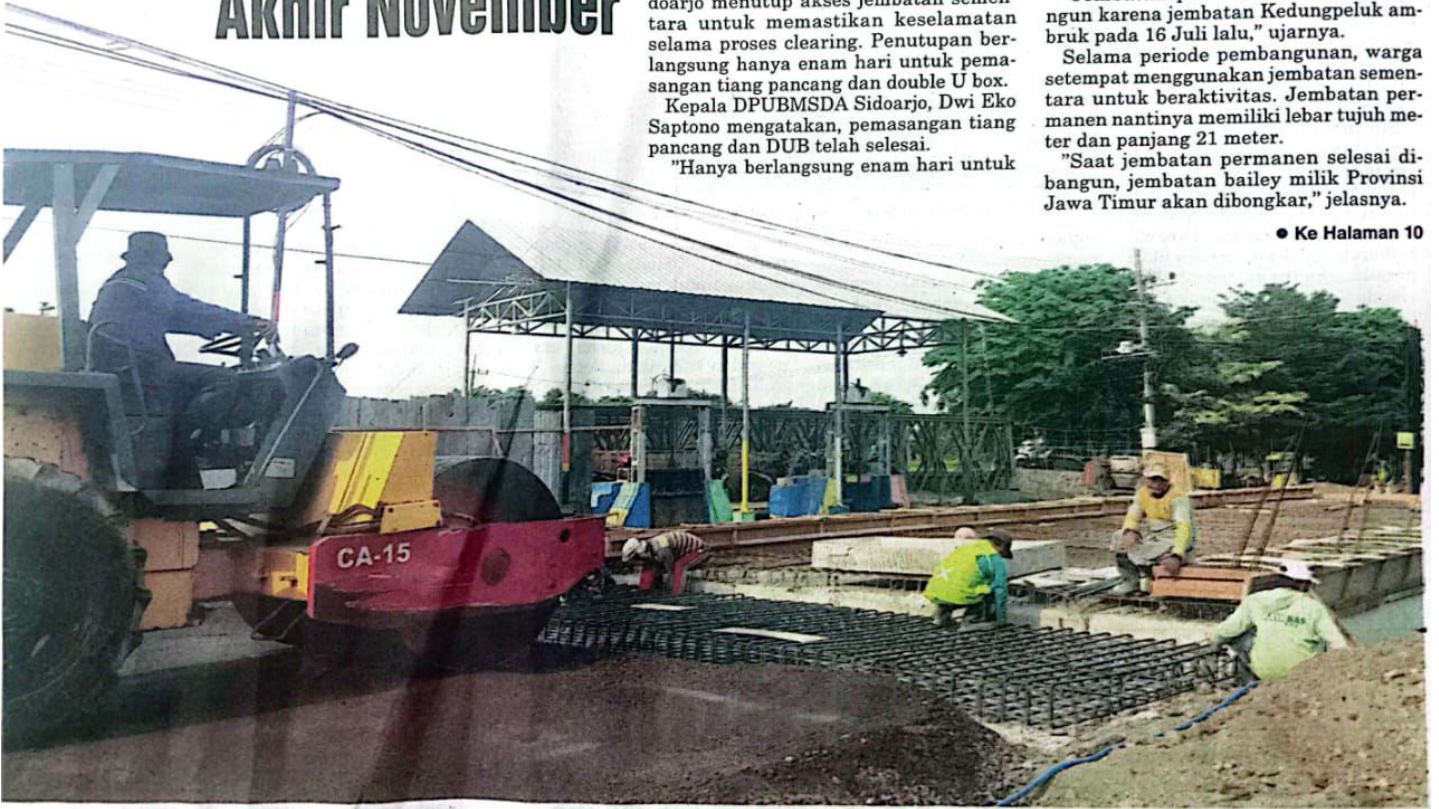
DIKERJAKAN: Jembatan permanen Desa Kedungpeluk Kecamatan Candi dalam proses pembangunan.
