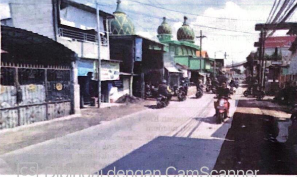
TAMBAH SALURAN: Jalan Geluran-Suko sudah rampung dibeton.
