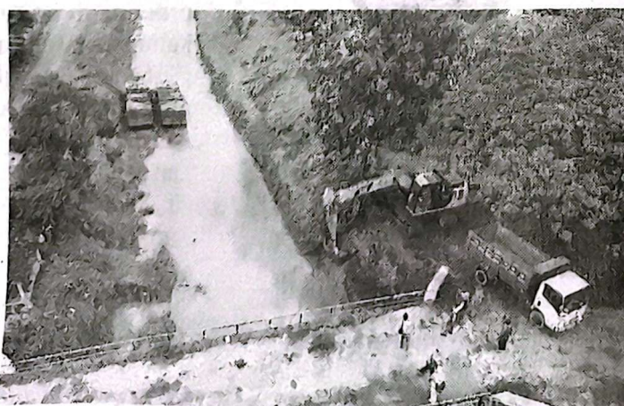
Alat berat melakukan pengerukan sampah dan sedimentasi di sungai.
