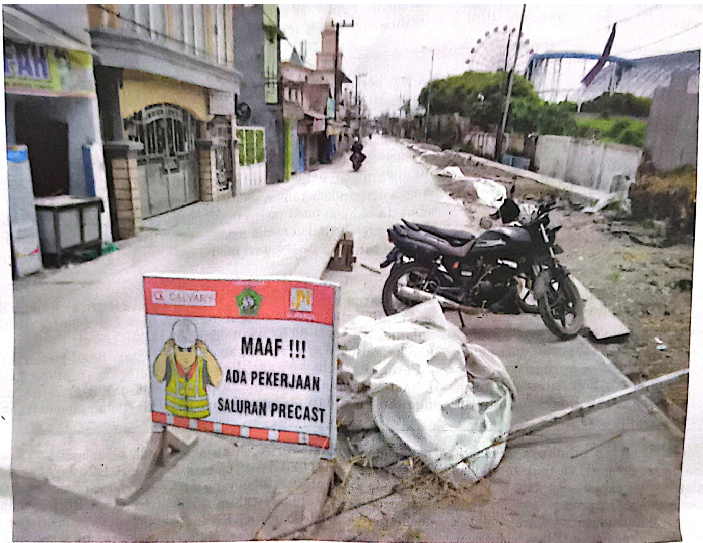
RAMPUNG: Betonisasi jalan di Kureksari-Ngingas, Waru, sudah selesai dikerjakan.
