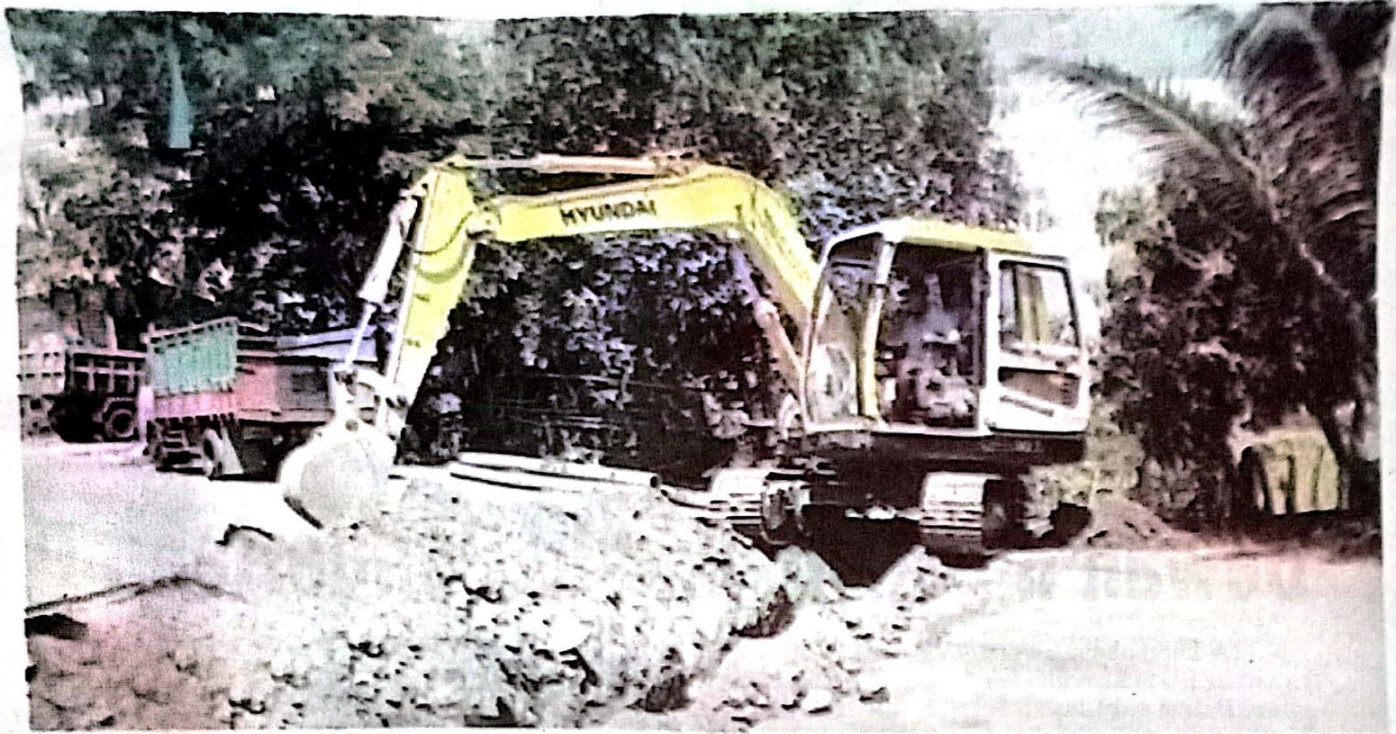
KEMARAU: Petugas Dinas PUBMSDA saat memasang pipa dan pompa di Desa Trompoasri, Jabon.
