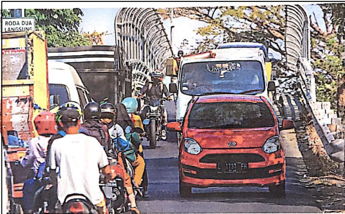
TERLALU SEMPIT: Kendaraan melintas di overpass Sepande, Candi, Semarang. Overpass yang baru akan memiliki lebar sekitar 7 meter.
