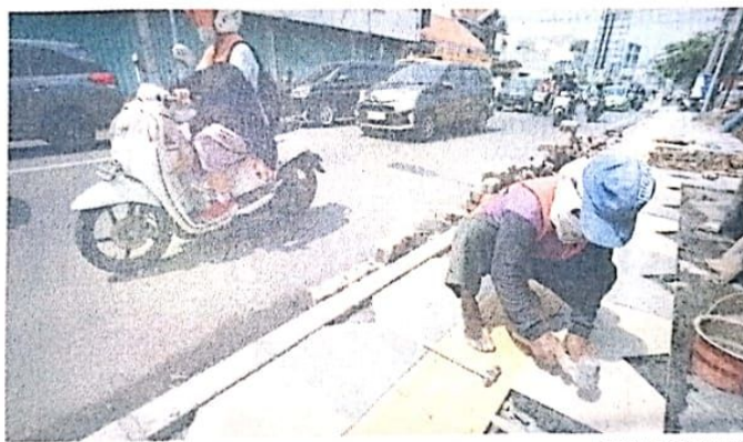
DIPERBAIKI: Pekerja menyelesaikan pemasangan keramik di trotoar Jalan Thamrin sisi utara kemarin.
