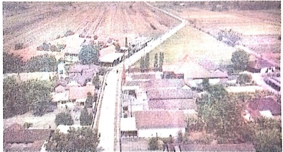
Foto dari udara betonisasi Tarik-Mlirip yang sudah kelar.
