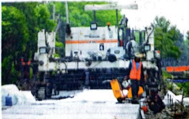
DIKEBUT: Betonisasi di sisi utara Jalan Lingkar Timur mulai dikerjakan dengan alat berat. Total jalur yang dibeton sepanjang 1,8 kilometer.
