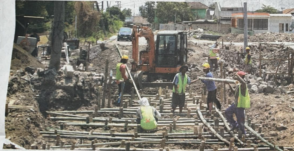
PROYEK LANJUTAN: Penyambungan Frontage Road Buduran diawali pengerukan untuk fondasi. Enam bangunan yang menghambat dibongkar bulan ini.
