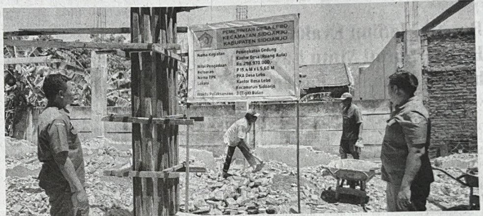
Perangkat Desa Lebo tinjau pembangunan ruang aula.
