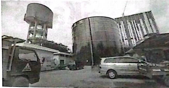
BERTAMBAH: Instalasi Pengolahan Air (IPA) yang ada di kantor Perumda Delta Tirta.
