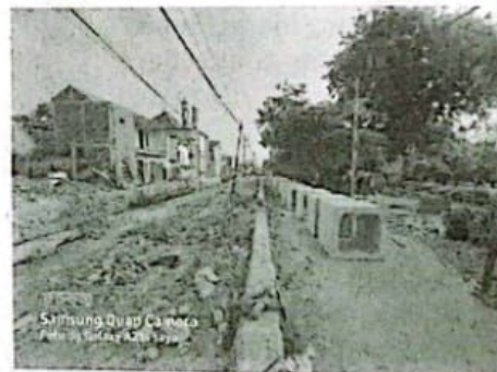
Proyek Frontage Buduran - Waru
