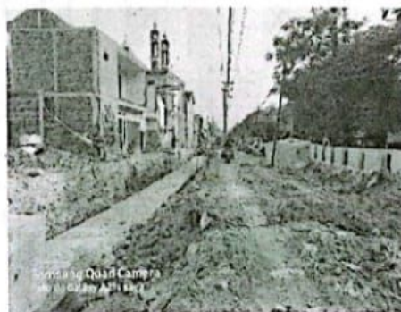
Proyek Frontage Buduran - Waru
