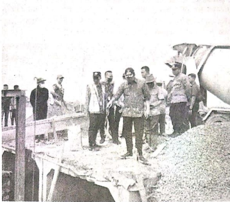
Bupati Sidoarjo Ahmad Muhdlor meninjau pembangunan rumah pompa di Tanggulangin.
