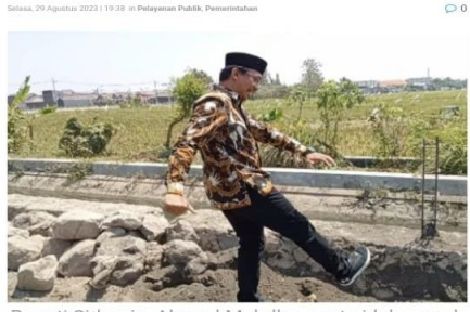
Bupati Sidoarjo, Ahmad Muhdlor, saat sidak proyek betonisasi jalan Banjarsari - Damarsi, Kecamatan Buduran, Sidoarjo / Foto: Ipong Syaiful
