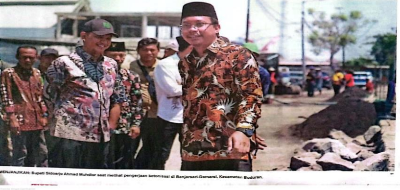
MELIHATKAN: Bupati Sidoarjo Ahmad Muhdlor saat melihat pengerjaan betonisasi di Banjarsari-Damarsi, Kecamatan Buduran.
