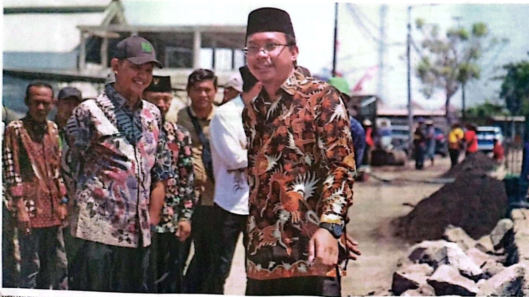
MENJAJAN: Bupati Sidoarjo Ahmad Muhdlor saat melihat pengerjaan betonisasi di Banjarsari-Damarsi, Kecamatan Buduran.
