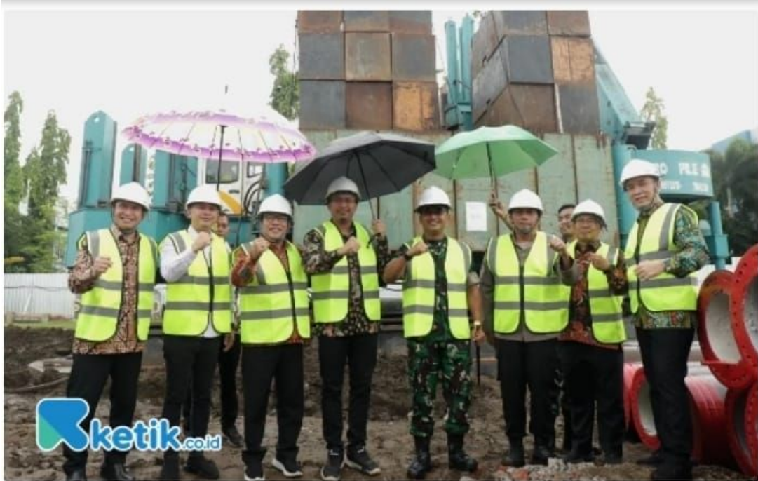
Bupati Ahmad Muhdlor (empat dari kiri) bersama jajaran Forkopimda Kabupaten Sidoarjo saat ground breaking pembangunan Gedung Pusat Terpadu (GPT) RSUD Sidoarjo pada awal Juli lalu. (Foto: Diskominfo Sidoarjo)
