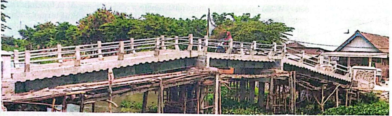
MENYEBERANG DENGAN AMAN: Pengendara melintas di Jembatan Klurak yang masuk tahap finishing kemarin (16/11).
