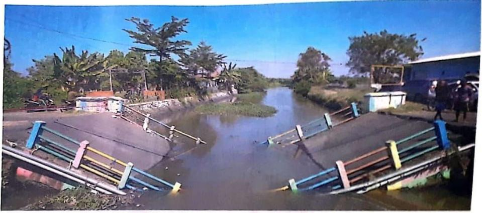
KEHILANGAN AKSES: Jembatan di Desa Kedungpeluk, Kecamatan Candi, Sidoarjo, patah setelah dilewati truk muatan pasir kemarin.
