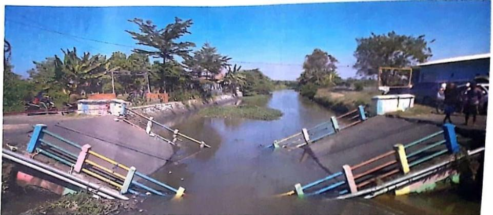
KEHILANGAN AKSES: Jembatan di Desa Kedungpeluk, Kecamatan Candi, Sidoarjo, patah setelah dilwati truk muatan pasir kemarin.
