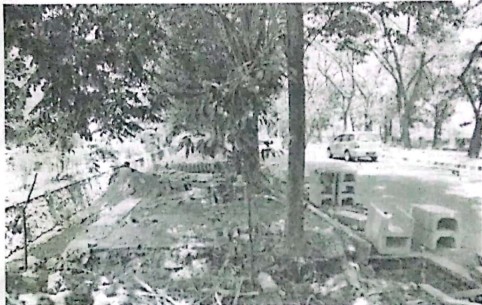
REVITALISASI - Pemkab Sidoarjo tengah merevitalisasi trotoar lingkar barat dengan mempercantik trotoar itu tepatnya mulai dari Kali Pucang hingga pintu masuk GOR Gelora Delta Sidoarjo sepanjang 1.210 meter, Senin (09/10/2023).
