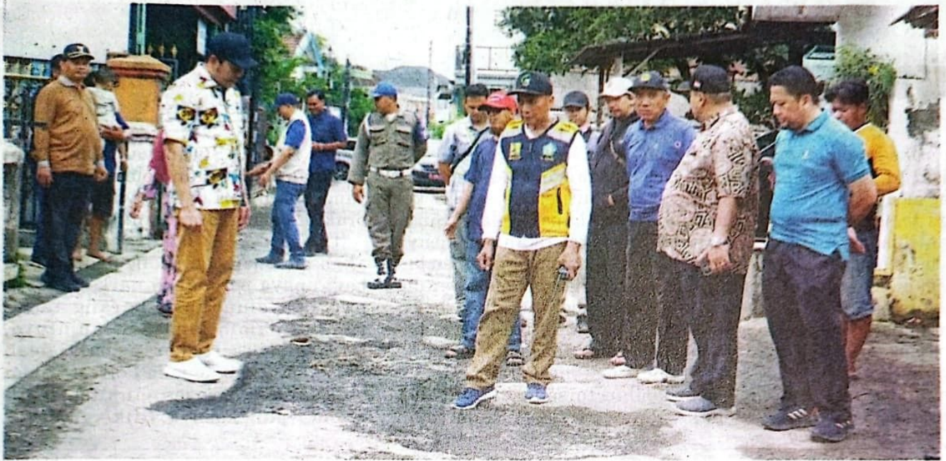
TEGAS: Bupati Sidoarjo Subandi saat melihat salah satu proyek perbaikan jalan.
