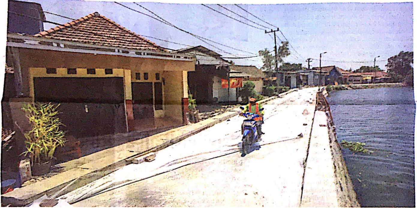
SESUAI TARGET: Kondisi proyek betonisasi ruas jalan Desa Tulangan–Durungbedug, Candi, kemarin (17/10). Betonisasi jalan sepanjang 1.450 meter dengan lebar 4 meter tersebut sudah nyaris separo. DIMAS MAULANA/JAWA POS
