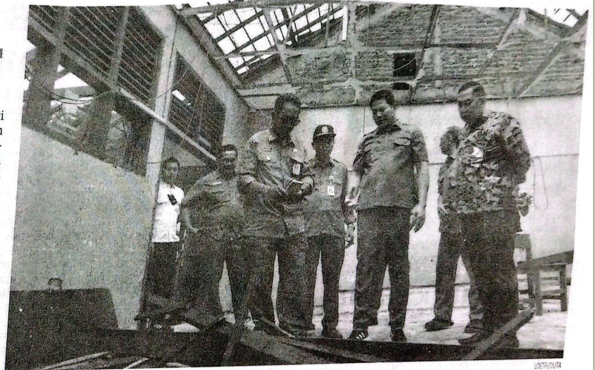
Bupati Sidoarjo Subandi sidak SMPN 1 Gedangan yang ambruk
