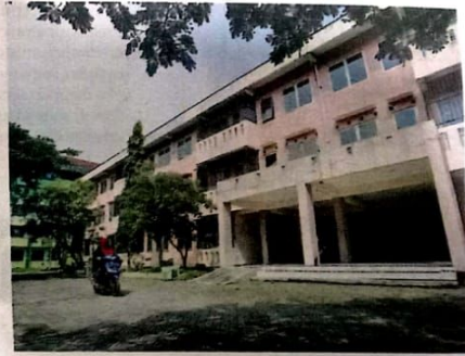
BERTAHUN-TAHUN MANGKRAK: Kondisi salah satu tower Rusunawa Bulusidokare yang tidak ditempati kemarin (23/1).
