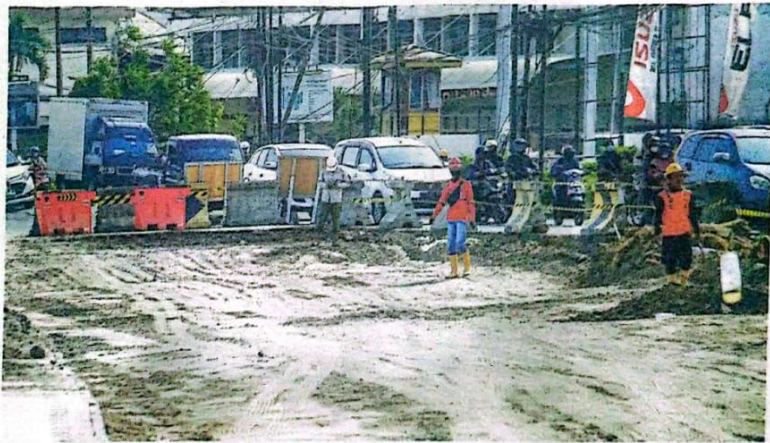
TINGGAL SEDIKIT LAGI: Kendaraan melintas di sekitar proyek pembangunan flyover Djuanda kemarin.
