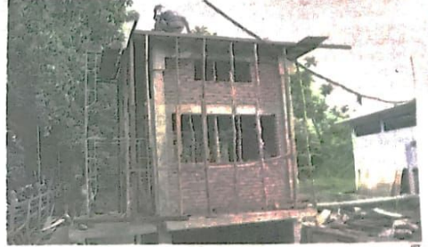
CEGAH GENANGAN: Rumah pompa di depan Lippo Plaza sedang proses pembangunan.
