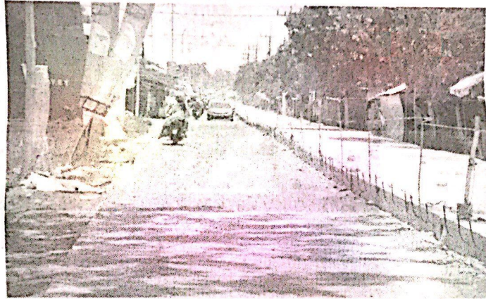
BETONISASI - Pemkab Sidoarjo terus mengebut proyek betonisasi. Diantaranya, proyek betonisasi penghubung Desa Suko, Kecamatan Sukodono - Desa Geluran, Kecamatan Taman dan proyek betonisasi Desa Banjarsari - Damarsi, Kecamatan Buduran, Sidoarjo, Rabu (11/10/2023).
