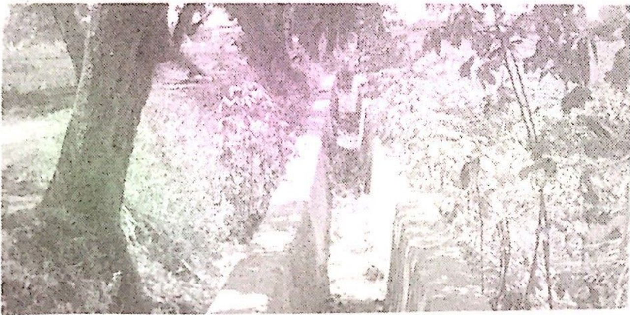
Pembangunan Saluran Irigasi ke Sawah desa Kepadangan.
