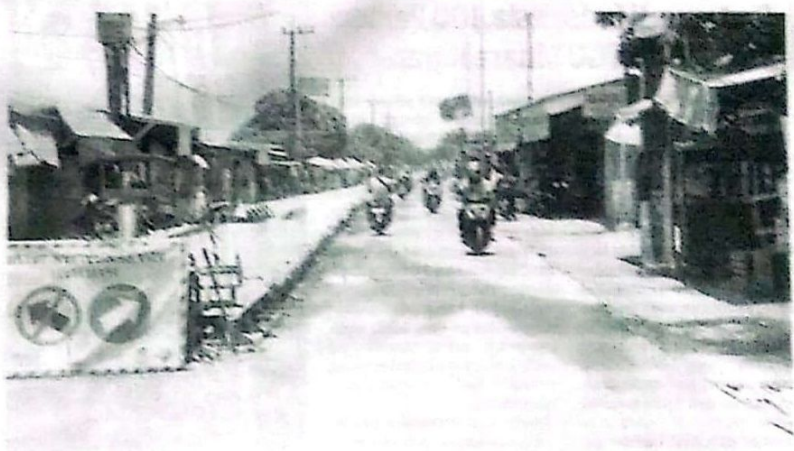
Proyek betonisasi Geluran - Suko dan Banjarsari - Damarsi, Kecamatan Buduran, Kabupaten Sidoarjo (11/10/23).
