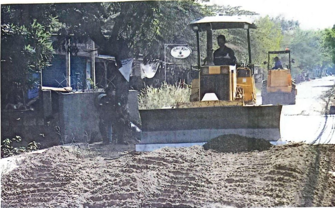
DITINGGIKAN: Alat berat meratakan jalan yang akan dibeton di depan Lapangan Banjarsari, Buduran, kemarin.
