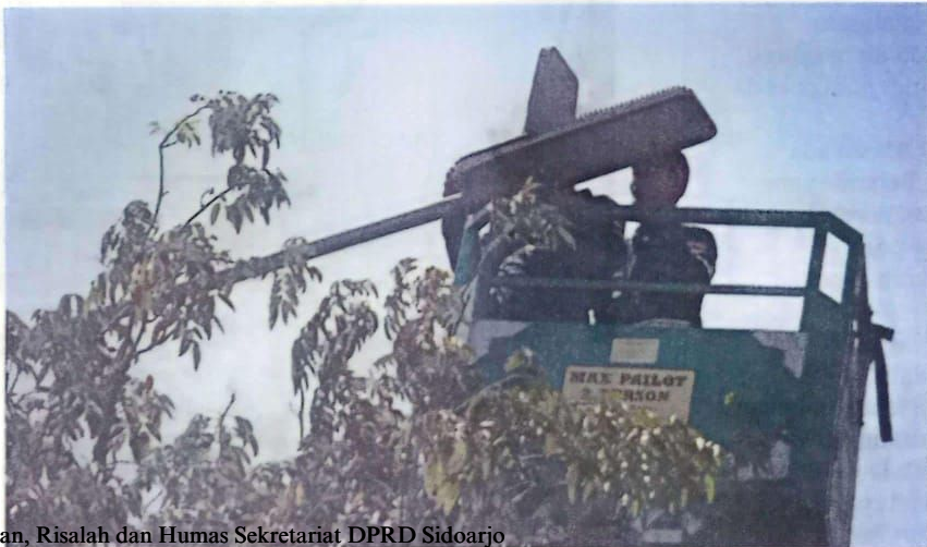
PEMELIHARAAN: Dinas Perhubungan Kabupaten Sidoarjo memperbaiki lampu penerangan jalan umum di Jalan Raya Pagerwojo kemarin.
