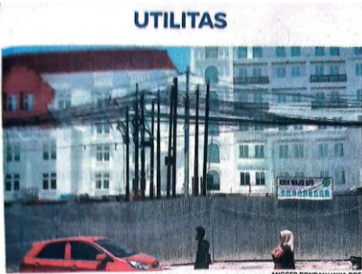
TAK RAPI: Kabel menjuntai mengganggu pembangunan double deck RSUD R.T. Notopuro Sidoarjo kemarin (13/10).
