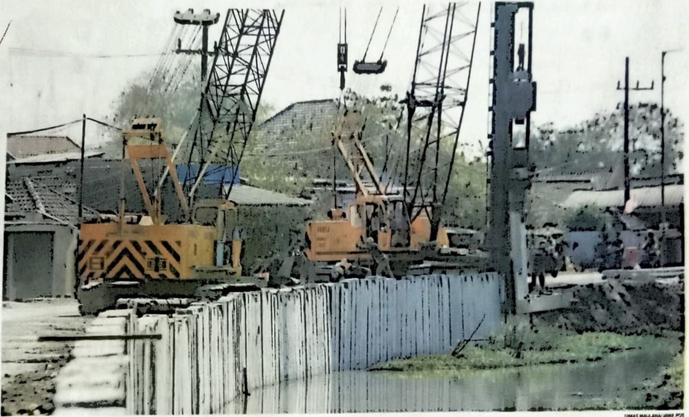
GARAP PENAHAN JALAN: Pekerja menggarap persiapan betonisasi di Jalan Raya Lajuk, Kecamatan Porong, kemarin. Titik ini masuk ruas Porong-Krembung yang dibeton tahun ini.
