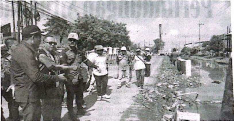
Bupati Sidoarjo Subandi mendengarkan paparan Kepala DPUBMSDA Dwi Eko Saptono saat sidak lokasi jalan yang hendak dibetonisasi.
