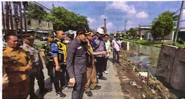
DITINJAU: Bupati Sidoarjo Subandi saat meninjau proyek betonisasi di Jalan Raya Desa Wedi, Kecamatan Gedangan.
