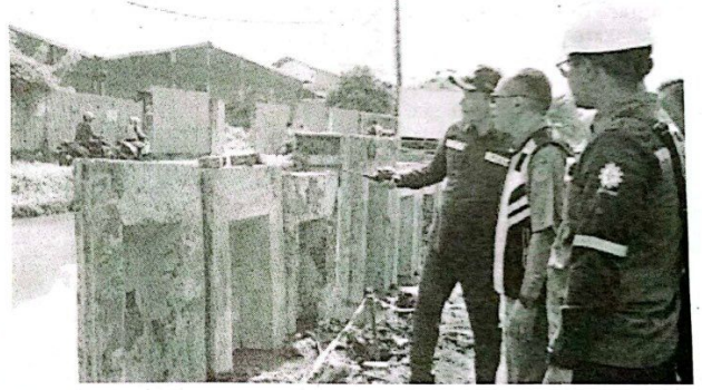
Bupati Subandi sidak proyek betonisasi Betro-Gedangan, Senin (19/5).
