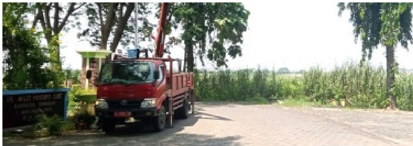
Petugas PJU Dishub sedang memperbaiki lampu penerang jalan di wilayah Medoro Klurak Candi Sidoarjo
