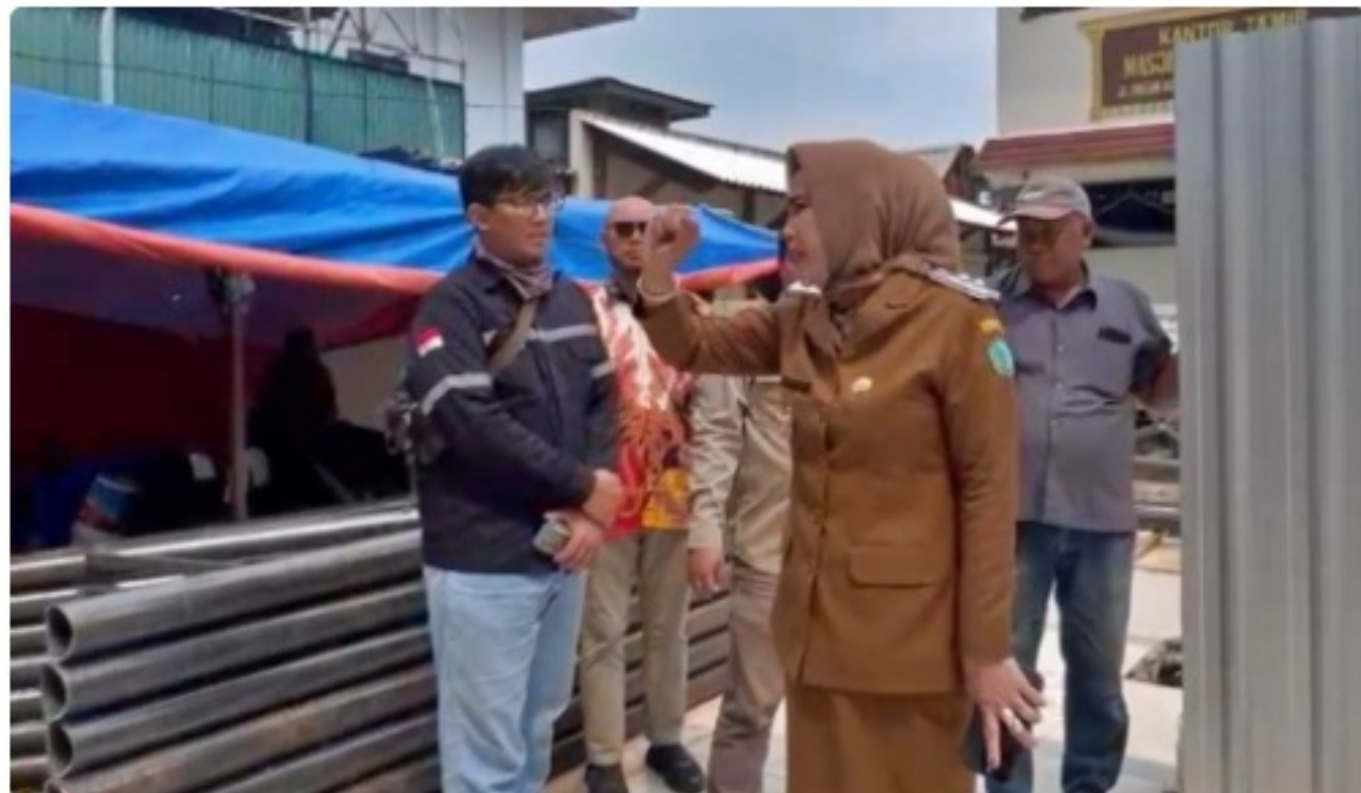
Wabup Sidoarjo, Hj. Mimik Idayana tegur mandor saat melakukan sidak proyek pembangunan rehabilitasi MAS.
