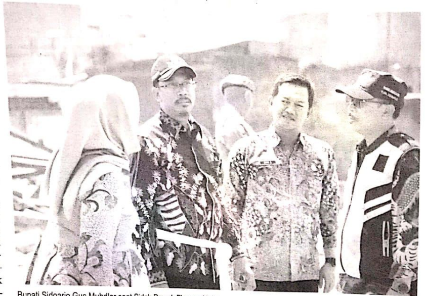
Bupati Sidoarjo Gus Muhdlor saat Sidak Proyek Flyover Aloha
