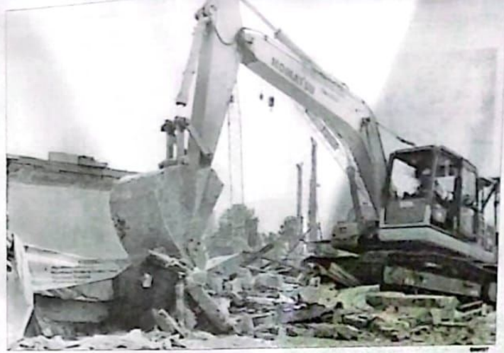
DIBONGKAR: Pembongkaran bangunan dalam Bundaran Aloha yang terkena proyek Flyover Aloha Gedangan.
