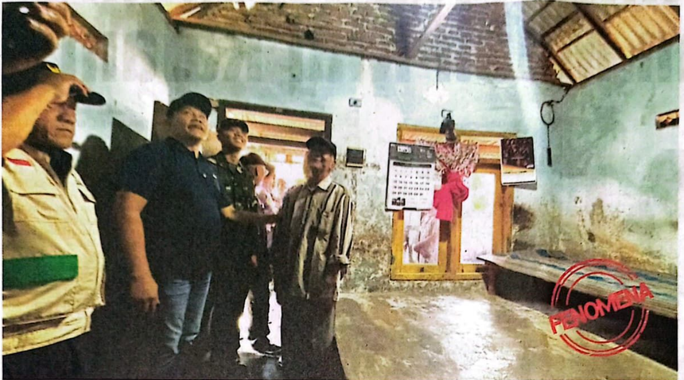
PEDULI: Bupati Sidoarjo Subandi mengecek kondisi rumah Abd Majid di Desa Semambung, Kecamatan Wonoayu, yang akan segera direnovasi melalui program bedah rumah.
